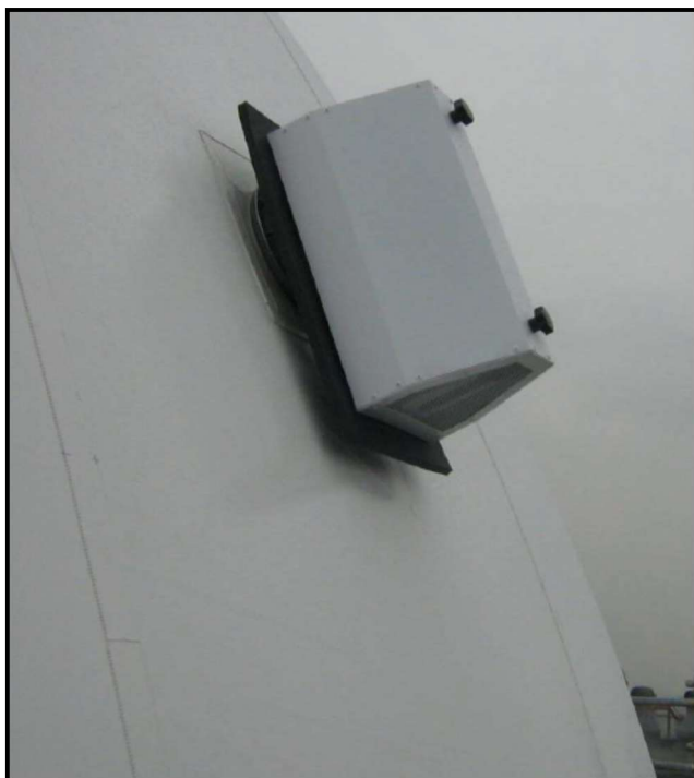
Figura 2.4 - Valvola sovrappressione aria
