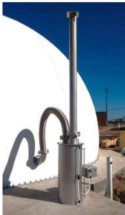
Figura 2.5 - Guardia idraulica
