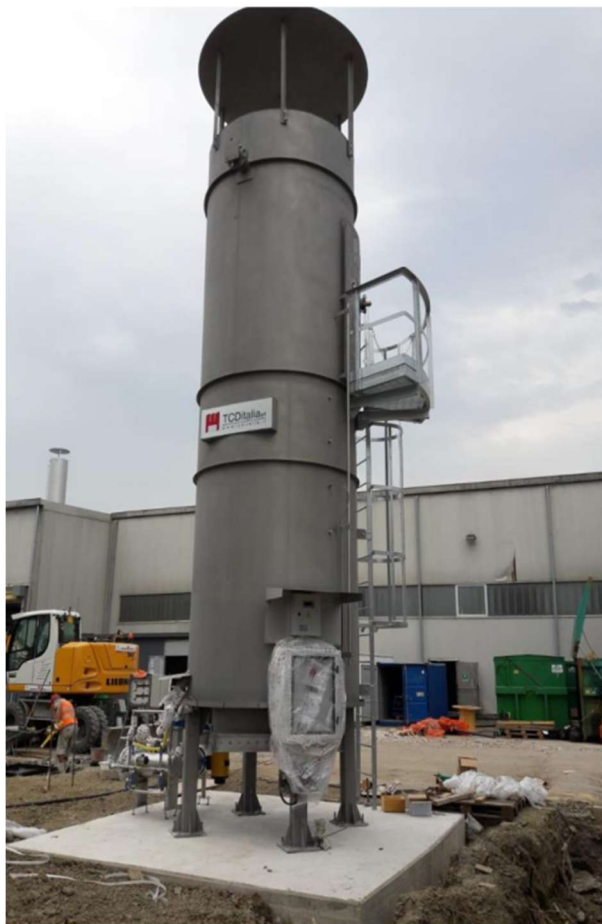
Figura 2.8 - Torcia biogas
